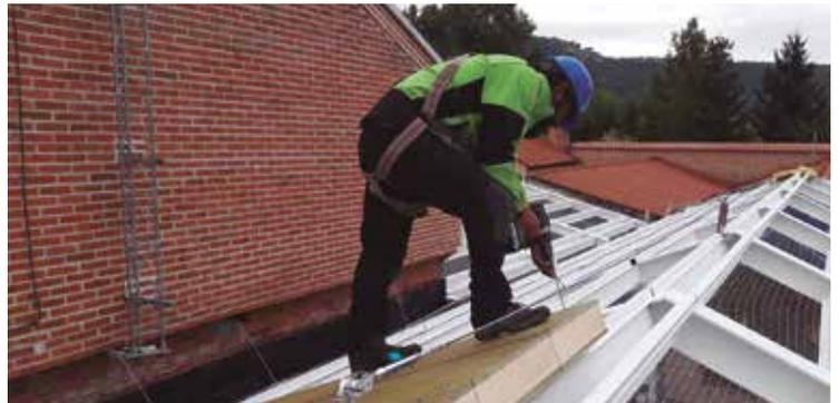
El panel sándwich ONDUTHERM proporciona el aislamiento necesario para tener una **buhardilla confortable**, tanto térmica como acústicamente.
