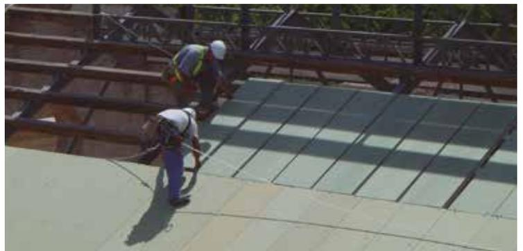
La rapidez y facilidad con la que se coloca el panel sándwich ONDUTHERM, permite, junto con **ahorro en estructura** debido a su ligereza y la **carencia de tiempos de espera**, que este sistema sea económico.
