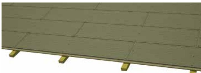
Sobre estructura metálica se recomienda la utilización de paneles con tablero aglomerado hidrófugo de 19mm en su cara exterior. Se recomienda hacer un pretaladro con broca de 1 mm de diámetro mayor que el de la fijación.
